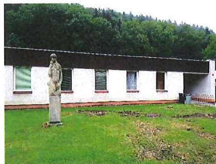
Objekt před realizací
